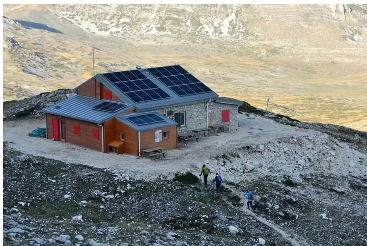
Fig. 5 Rifugio Sebastiani dopo i lavori di ristrutturazione
