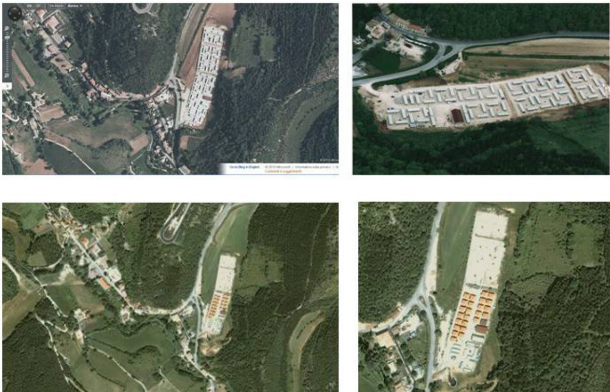
Figura 1 – Casenove (Umbria): campi container e successiva realizzazione di nuove case
